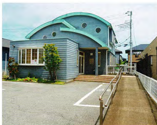
外観。車椅子用の長いスロープがある。
